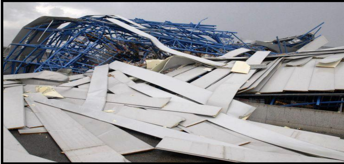
A sinistra: Collasso della trave trasversale di un edificio monopiano
