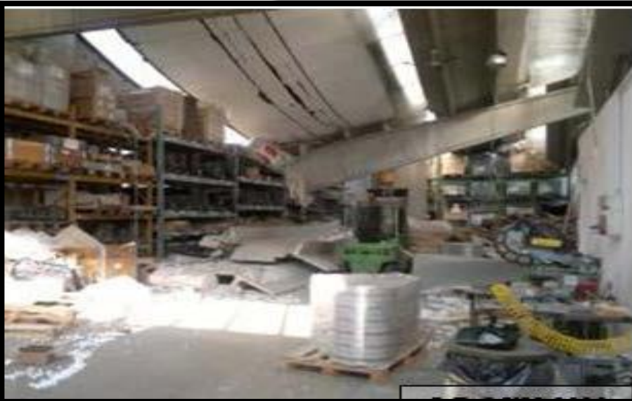
A sinistra: Collasso della trave trasversale di un edificio monopiano
